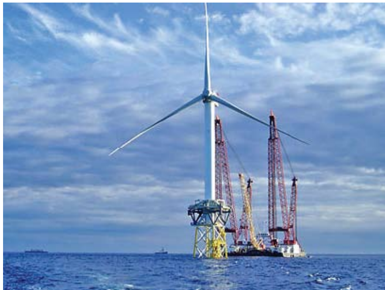
Slika 18: Gradnja vetrnice na morju
