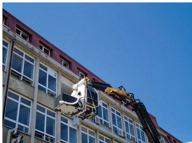
Slika 1: Vnos instrumenta XPS v Laboratorij za analizno kemijo in industrijsko analizo Fakultete za kemijo in kemijsko tehnologijo Univerze v Mariboru
