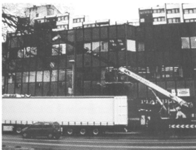
Slika 2: Transport naprave z avtodvigalom v prvo nadstropje poslovno-stanovanjskega centra v Domžalah, kjer je Center za trde prevleke
