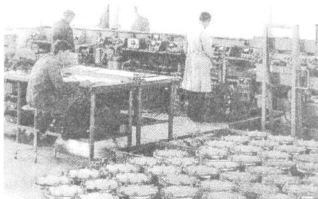
Slika 4 Serijska proizvodnja difuzijskih črpalk (1962)
