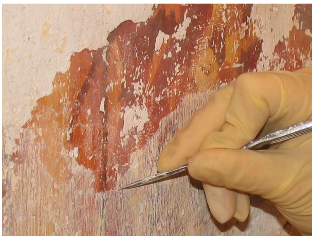
Odstranjevanje sige s skalpelom (levo) in kitanje na mestih manjkajočih oz. odstranjenih ometov (desno).
