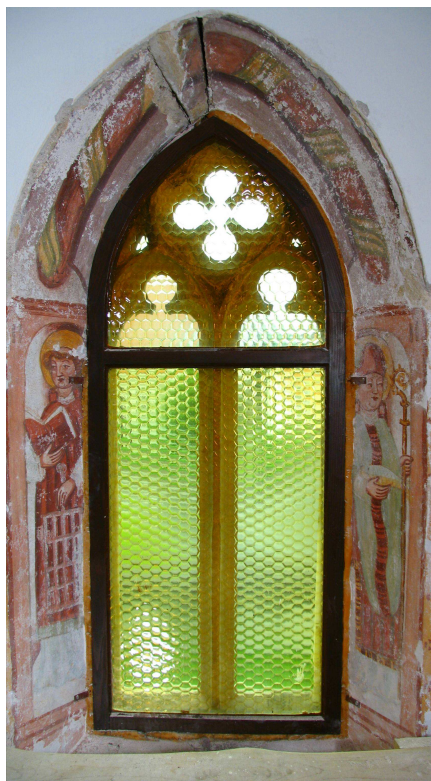
Okno na V steni prezbiterija pred (levo) in po zamenjavi zasteklitve in obnovi kamnitih elementov.
