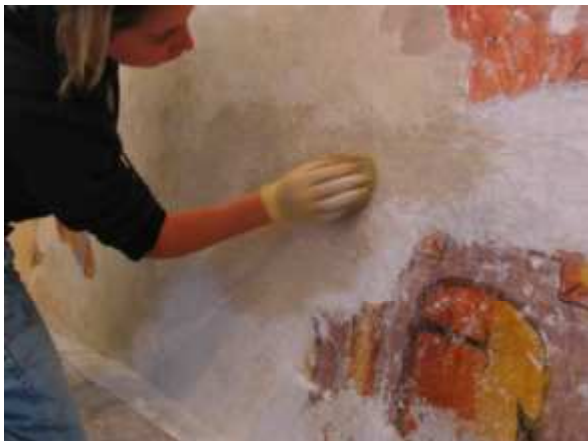
Toniranje na novo narejenih ometov (levo). Tonirani novo narejeni ometi okoli prezentiranih fresk (desno)
