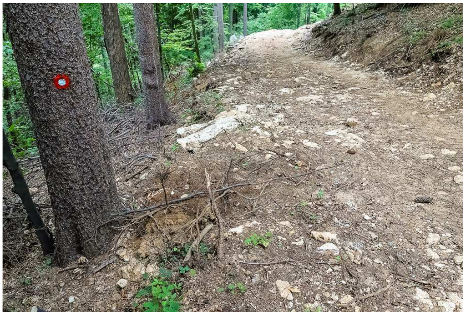
Slika 6: Gozdna vlaka na pobočju Gore Oljke nima prečnih kanalov za odvodnjavanje.
