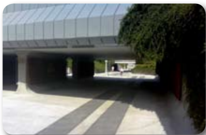
Obnovljen podhod Tivoli
