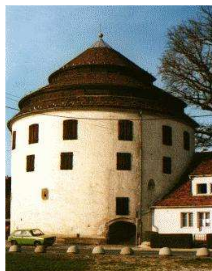
Sodni stolp po rekonstrukciji fasadnih ometov leta 1974.
