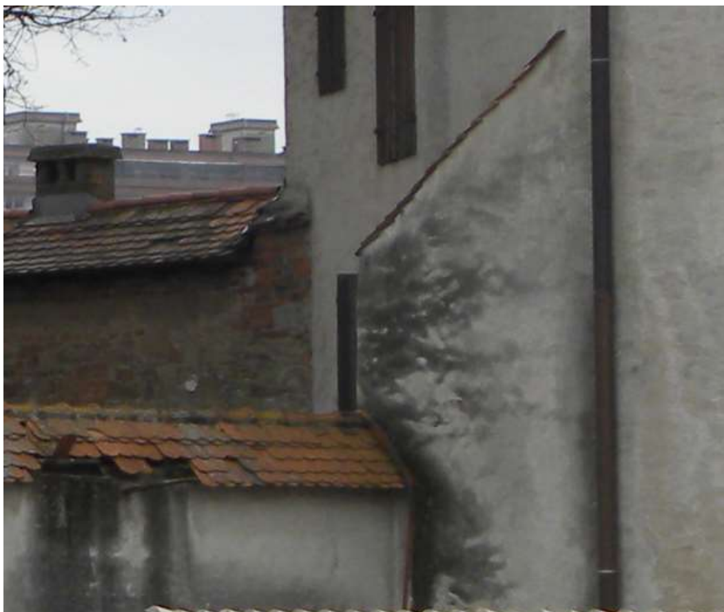
Nekdanja višja višina zahodnega obzidja je nakazana na stiku s Sodnim stolpom
