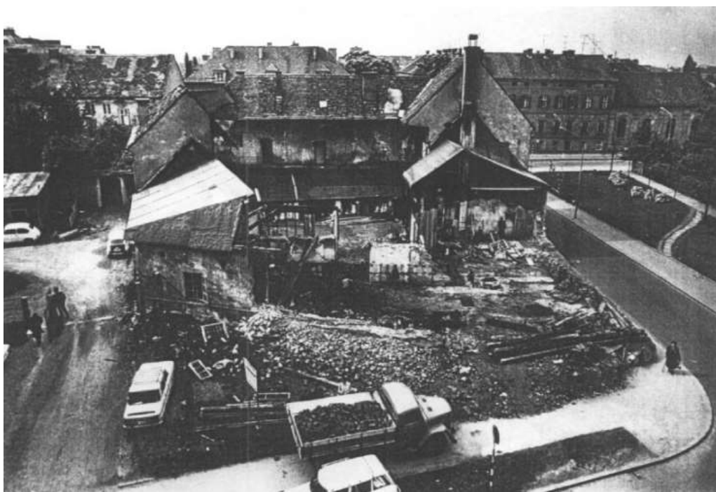
Leta 1972 pogoreli objekt na lokaciji severozahodnega stolpa mariborskega mestnega obzidja. Arhiv Zavoda za varstvo kulturne dediščine Slovenije OE Maribor.
