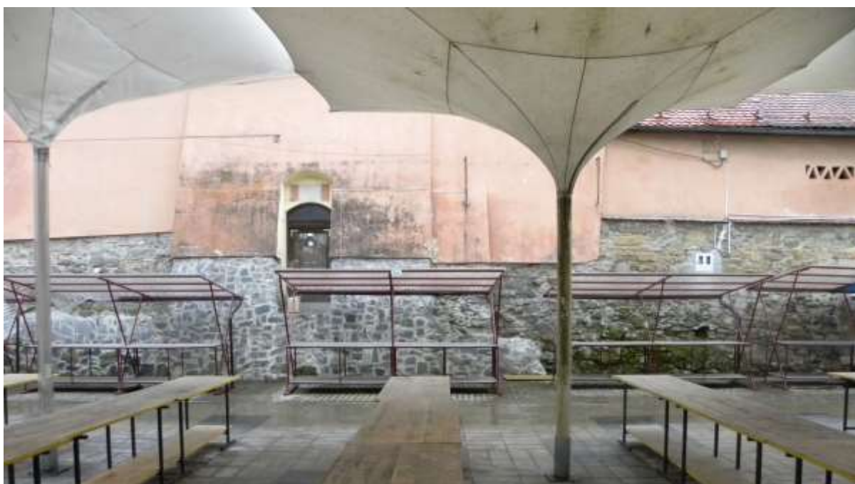
V 16. in 17. stoletju so obzidje na več lokacijah na zunanji strani okrepili s kontrafori in tako preprečili nagibanje navzven proti jarku. Ohranila sta se okrepitvi južnega dela zahodne obzidne stranice na območju sedanje tržnice.
