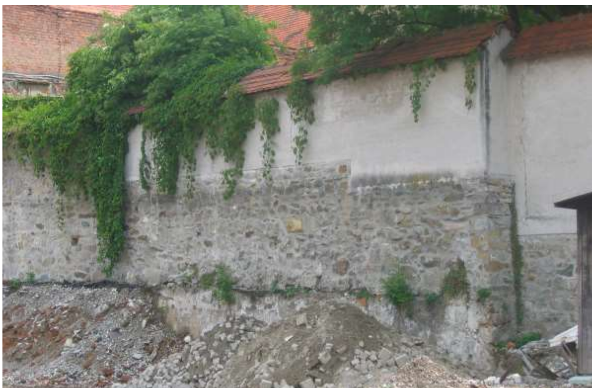
Ponovno zgrajeni del mestnega obzidja ob Sodnem stolpu v Mariboru leta 2008. Arhiv ZVKDS OE Maribor.
