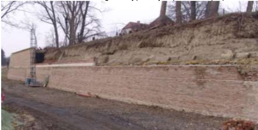
bastija med gradnjo
