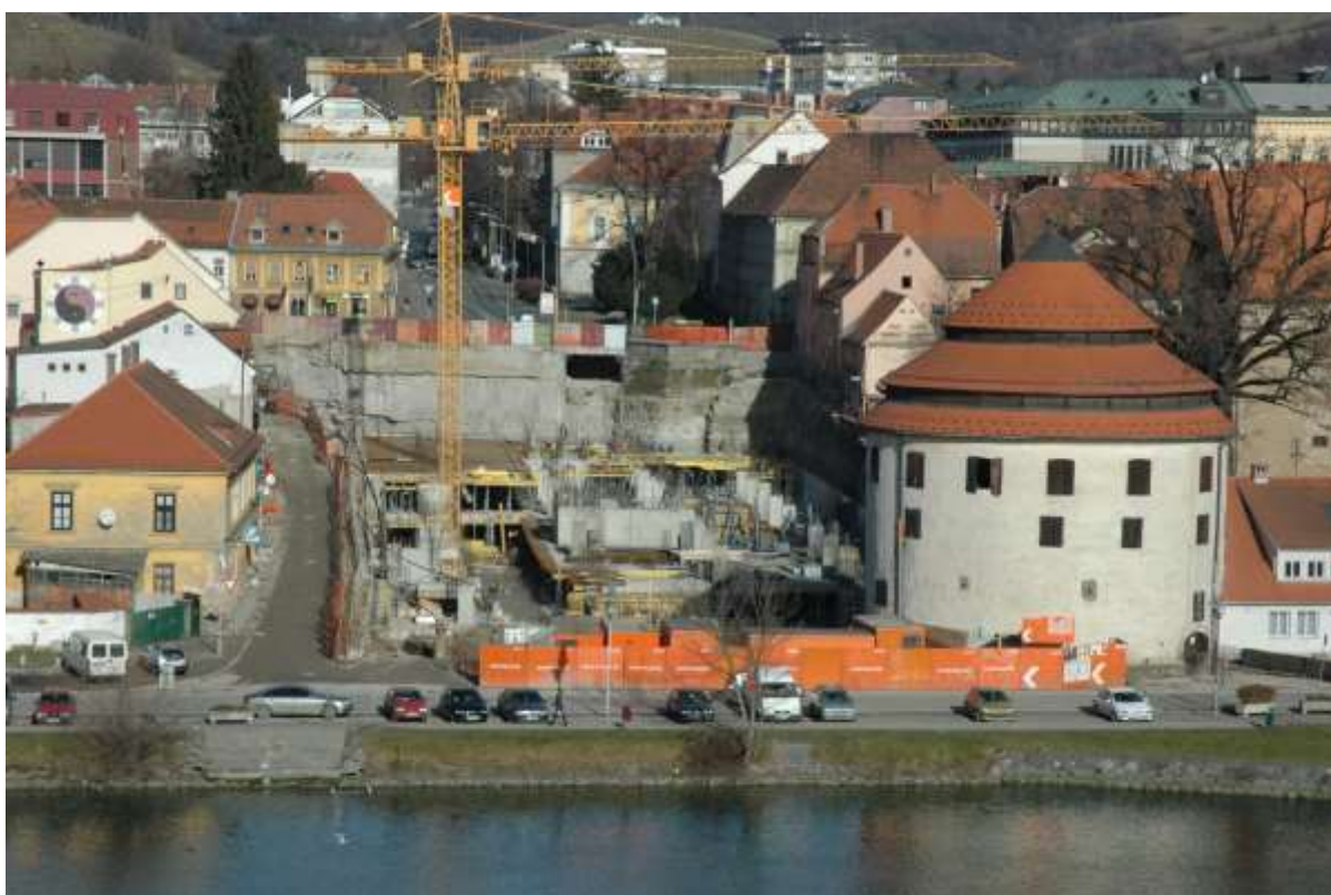
Širina in globina obrambnega jarka sta se pokazali tudi ob gradnji nove tržnice pred nekdanjo zahodno stranico obzidja.
