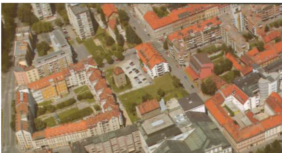
Izolirani Čeligijev stolp po porušenju obzidja sredi nove pozidave.
