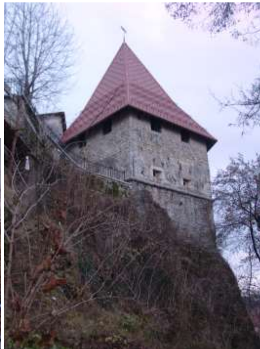
po dokončani obnovi
