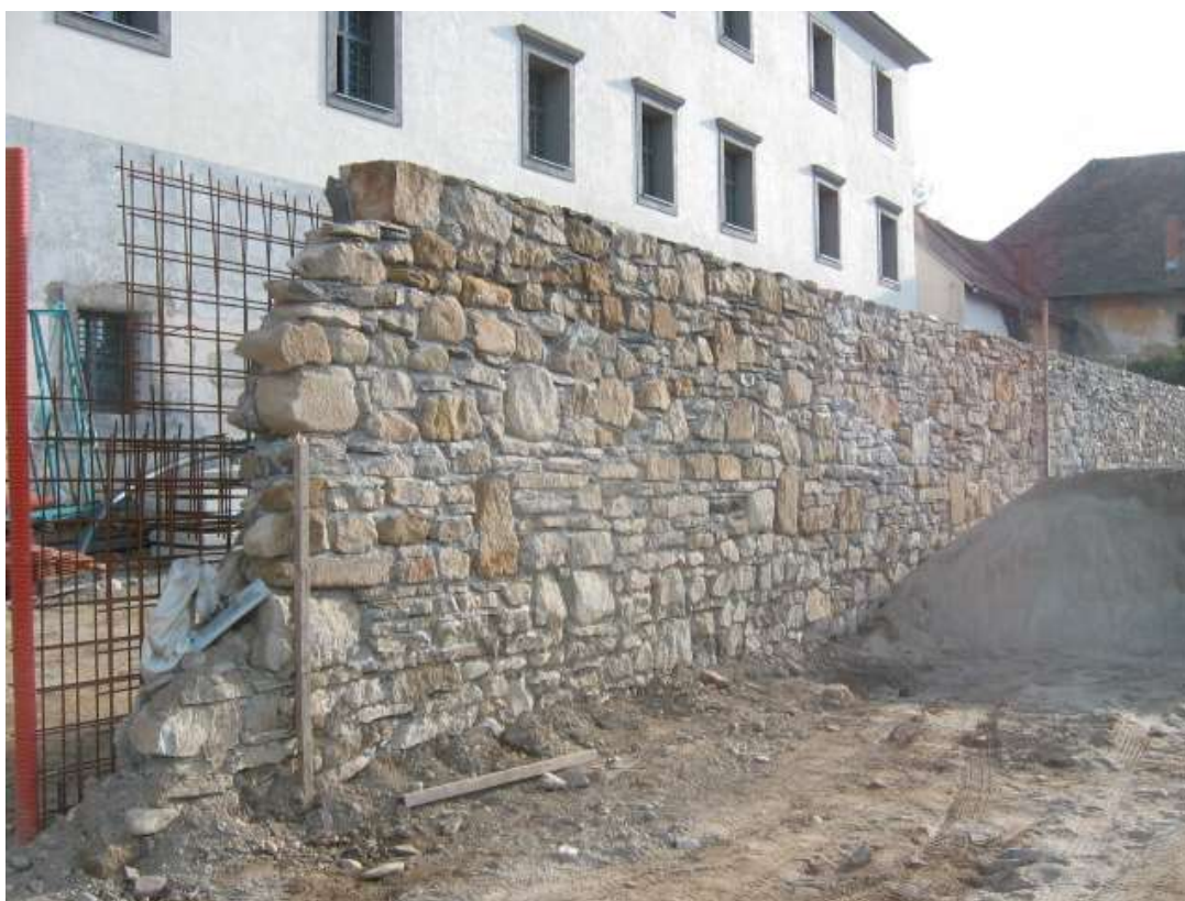
Ponovno zgrajeni del južnega mestnega obzidja ob minoritskem samostanu v Mariboru leta 2010. Arhiv ZVKDS OE Maribor.
