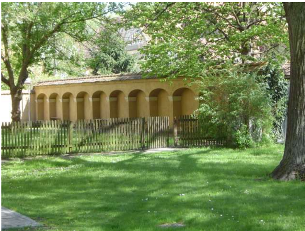
Sanirani pokopališki zid z nišami za obzidjem v Radgoni (Bad Radkersburg)
