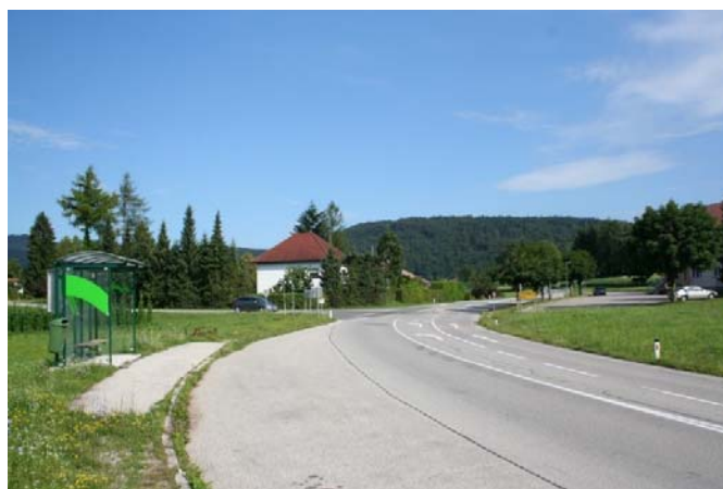
Slika 23: Križišče v Gabrovčcu nima urejenih ustreznih površin in prehoda za pešce
