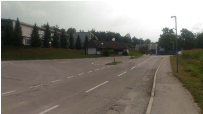
Slika 10: Avtobusno postajališče pri matični šoli je opredeljeno kot nevarno mesto
