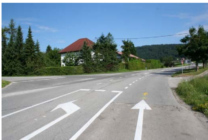
Slika 22: Križišče v Gabrovčcu nima urejenih ustreznih površin in prehoda za pešce
