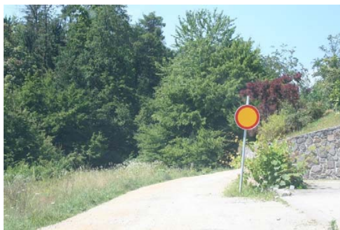
Slika 15: Cesta čez "Kojino" nima ustreznih površin za pešce
