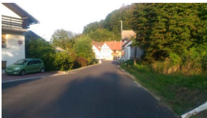
Slika 28: Višnja Gora – tudi po rekonstrukciji ceste še vedno ni urejenih površin za pešce
