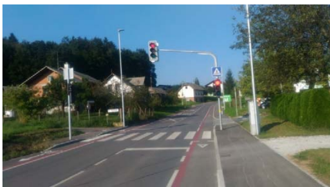
Slika 14: Prehod za pešce na Ljubljanski ulici v Ivančni Gorici je opremljen s semaforjem s hitrostno zaporo
