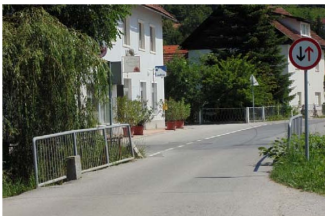
Slika 26: Ozek most na ulici Cesta na Polževo
