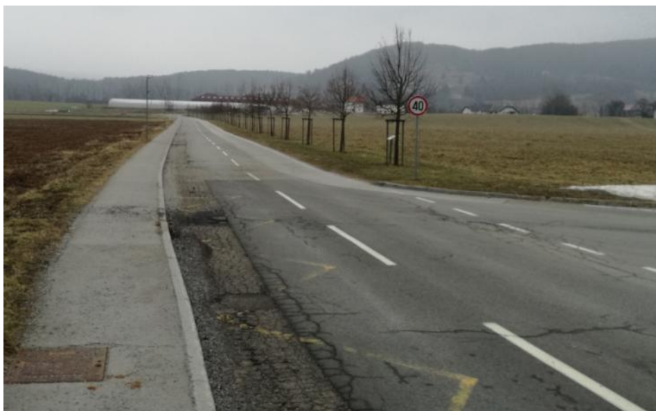
Slika 10: Prometna infrastruktura na območju OŠ Stična
