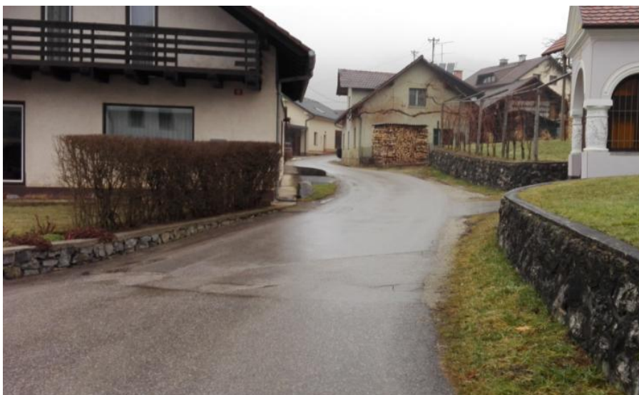
Slika 46: Stranske ceste in ulice v naselju Krka so izvedene brez hodnikov za pešce
