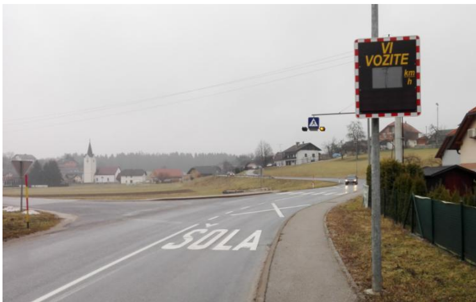
Slika 12: Obstoječi hodnik in prehod za pešce v naselju Muljava
