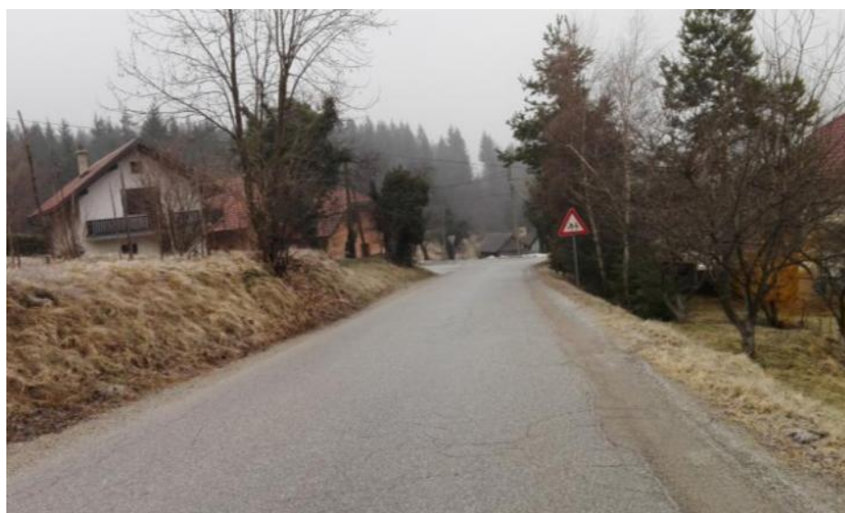
Slika 54: Cesta skozi Ambrus je izvedena brez urejenih površin za pešce
