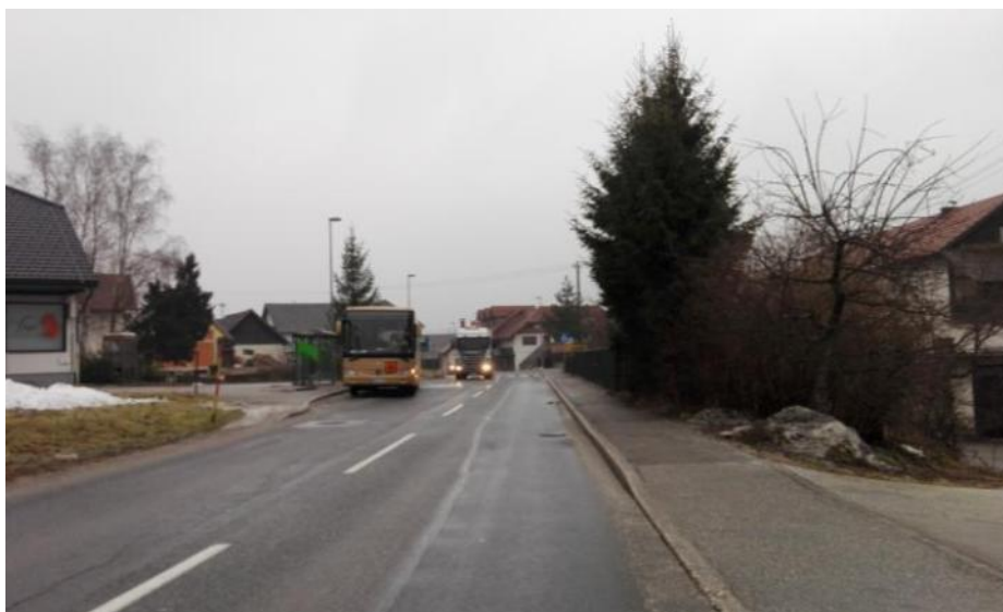
Slika 51: Urejena prometna infrastruktura na regionalni cesti R1-216/1175 Krka-Žužemberk
