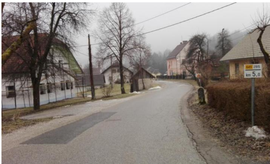
Slika 55: Cesta skozi Ambrus je izvedena brez urejenih površin za pešce
