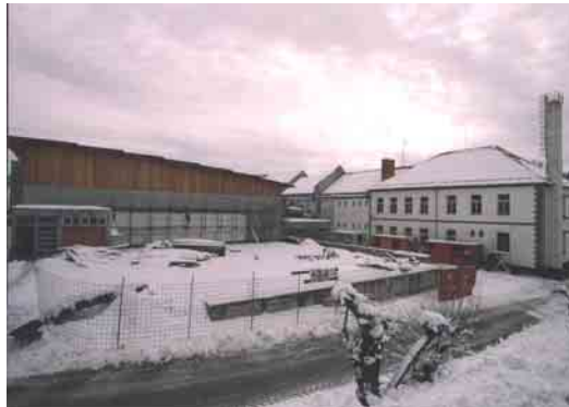
Gradnja športne dvorane se bliža koncu (Foto: S. Feguš)
