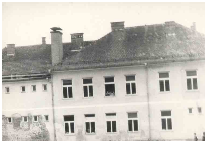
Šola je bila potrebna temeljite obnove (Foto: S. Feguš)
