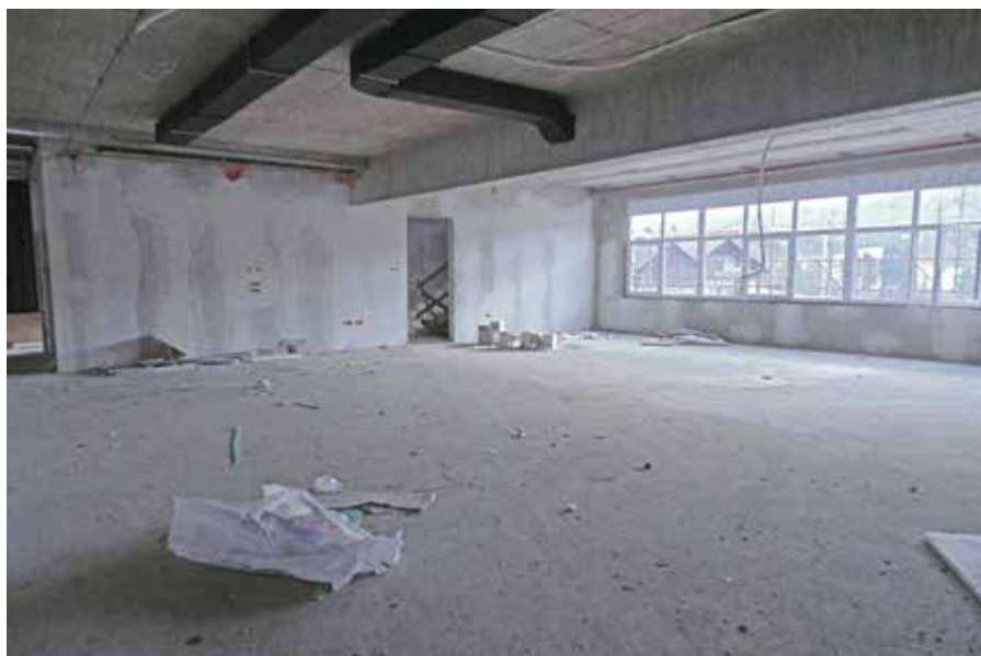
Notranjost šole med gradnjo
