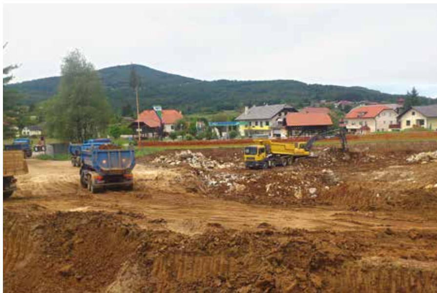
Začetek gradnje nove šole
