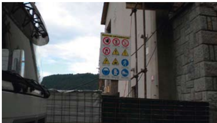
Začela so se obnovitvena dela ...
