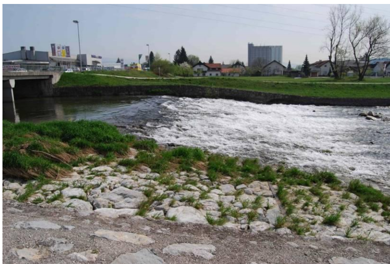
Pod mostom za glavno cesto med Domžalami in Virom
