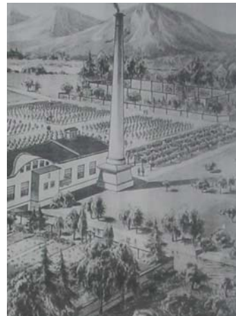
Slika 3: Dimnik pri nekdanji Ladstatterjevi tovarni
