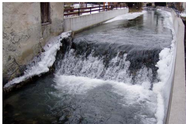
Pogled proti toku Mlinščice pri nekdanjem Trnavčevem mlinu. O perišču ni več sledov.
