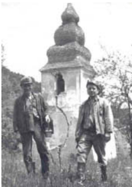
Slika: Jamska minerja se pripravljata, da bosta raztrelila nevarno nagnjen zvonik govške cerkve.
