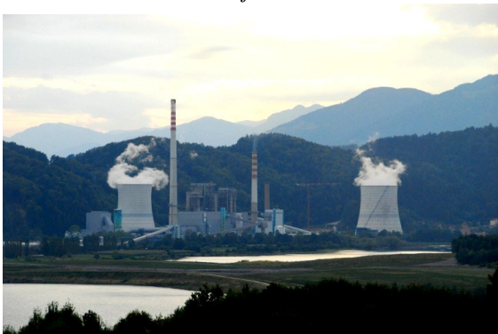
Termoelektrarna v Šoštanju. Veliki široki "dimniki", iz katerih se vali bel dim, sploh niso dimniki, temveč hladilni stolpi, bel "dim" pa je zgolj vlažen zrak. Torej neke vrste oblak. Dimnika sta ozka in visoka.
