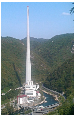
Termoelektrarna v Trbovljah
