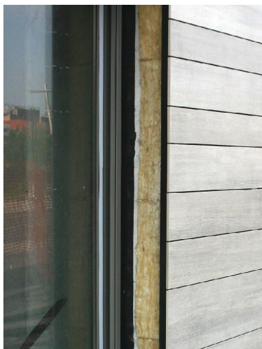
Hišo izoliramo in s tem zmanjšamo uhajanje toplote v okolico.
