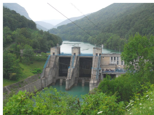
Hidroelektrarna v Solkanu
