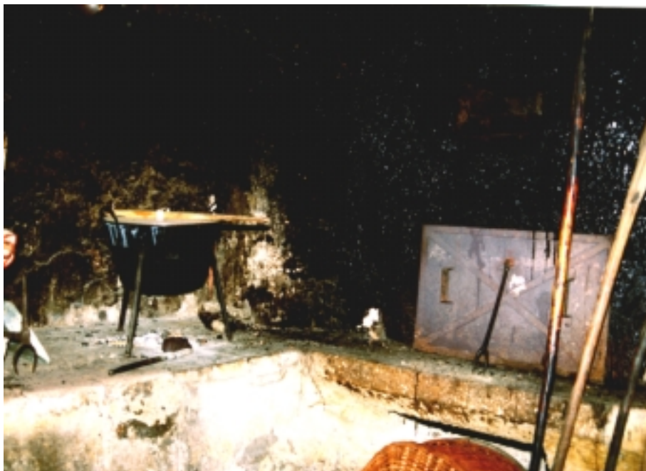
Slika 15 Kurišče za krušno peč in ognjišče za kuho
