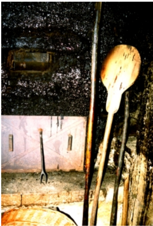
Slika 17 Kurišče za peč s prislonjenim pokrovom in zgoraj odprtino za vleko, ob strani lopar za vstavljanje kruha v peč.
