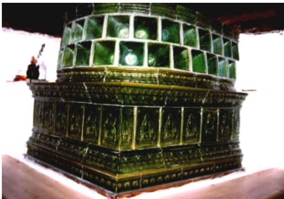
Slika 39 Obnovljena peč v zgornji "hiši", zgornji del še iz starih pečnic.
