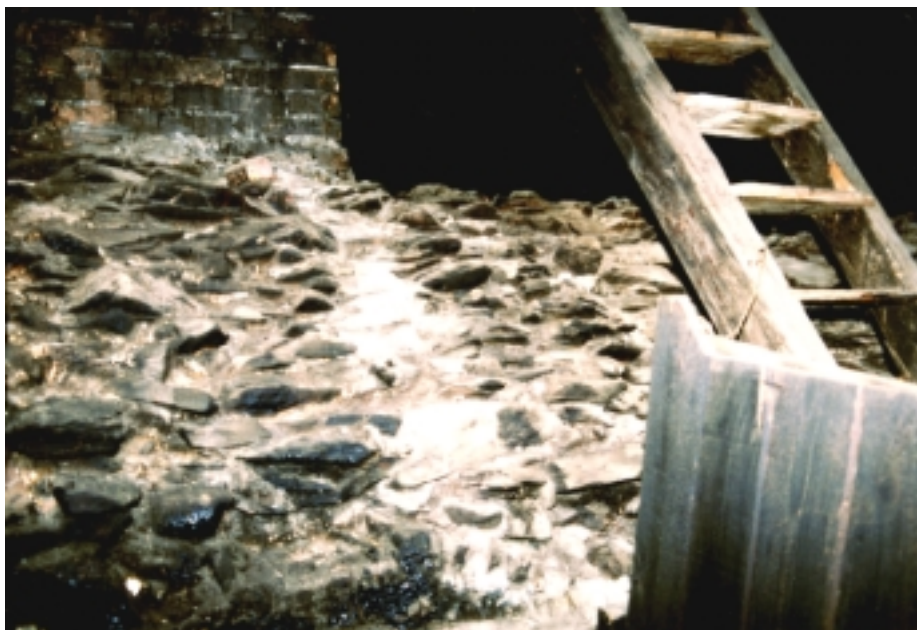
Slika 38 Velb črne kuhinje z zgornje strani iz kamna, delno se vidi dimnik, poleg so stopnice na podstreho.
