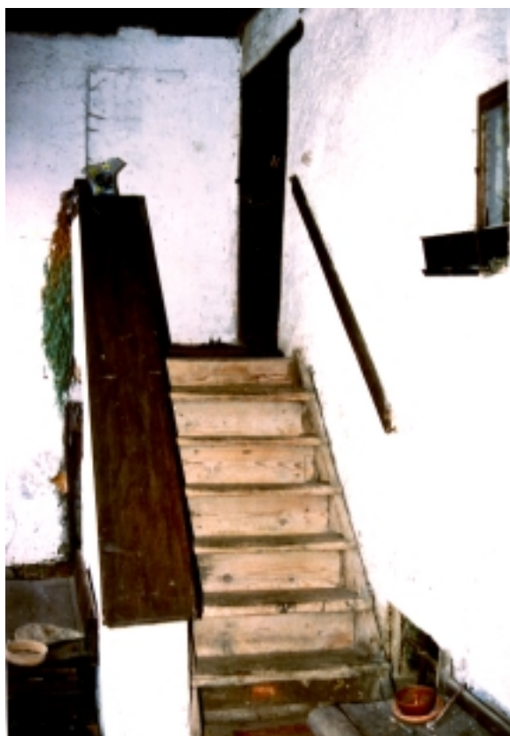
Slika 49 Stopnice z dvorišča v spodnjo hišo.
