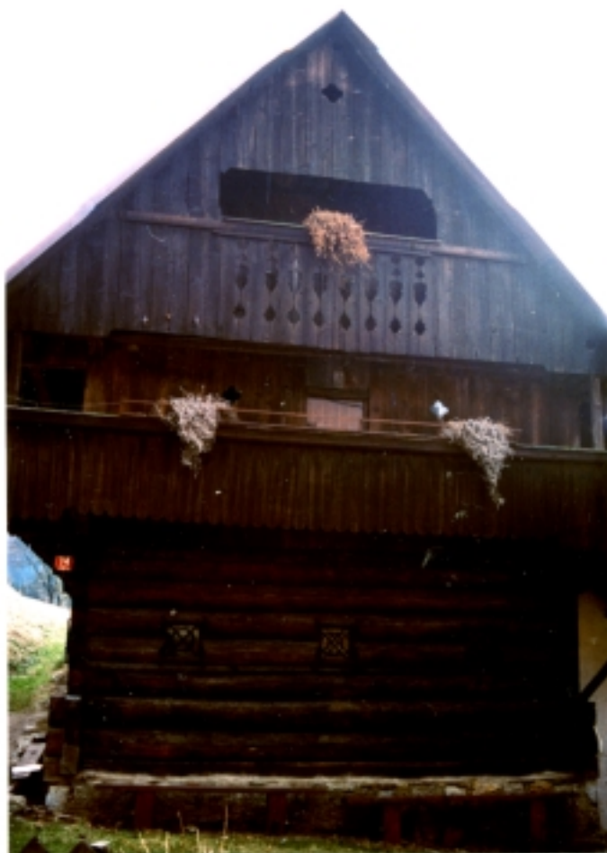
Slika 4 Severna stran Polenčeve hiše s hišno številko 74
