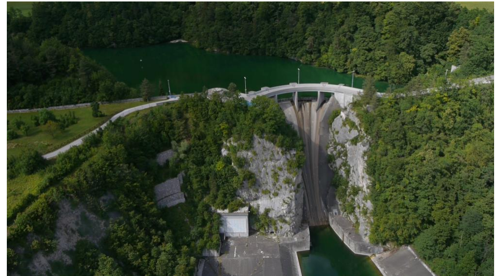
Hidroelektrarna Moste (reka Sava)
