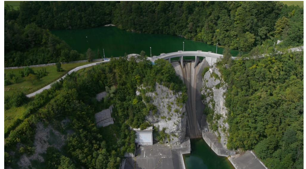
Hidroelektrarna Moste (reka Sava)
