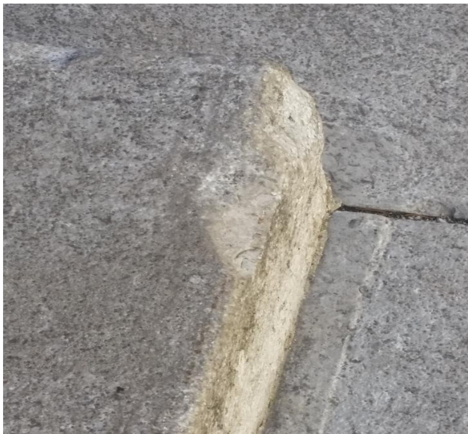
Sliki 23 in 24: Malo odkrhnjeni stebrni podstavki pročelja (foto: U. Žun)
