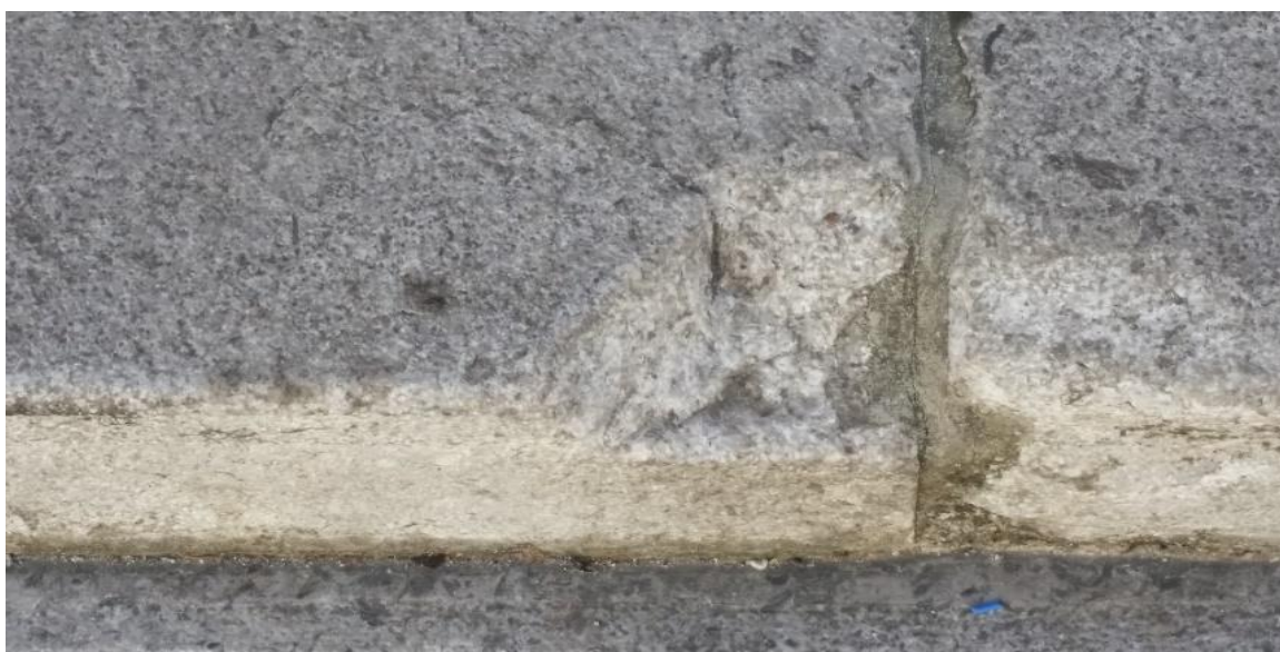
Sliki 23 in 24: Malo odkrhnjeni stebrni podstavki pročelja (foto: U. Žun)
