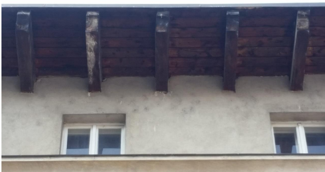
Slika 21: Pred časom obnovljena streha s spodnje strani (foto: U. Žun)
