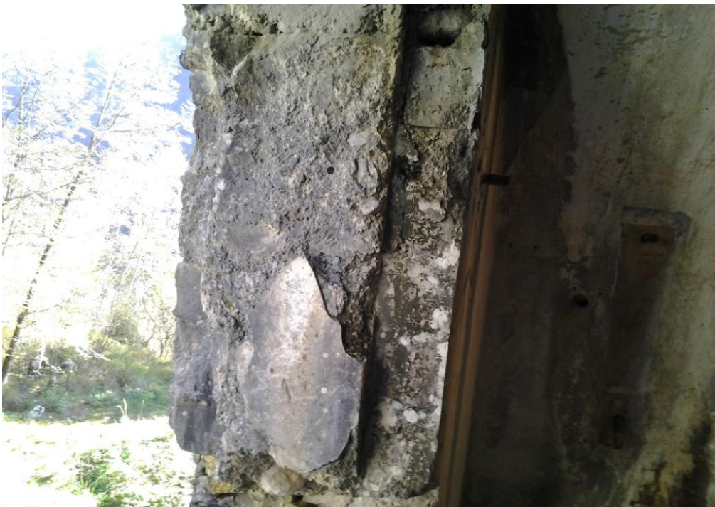
Slika 6: Debelina stene na strani, ki ni bila izpostavljena obstreljevanju (foto: U. Žun)
