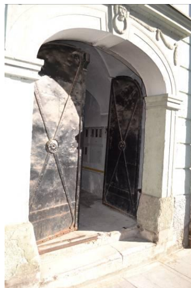
Slika 8: Protipožarna gradnja – železna vrata in kamniti podboj
