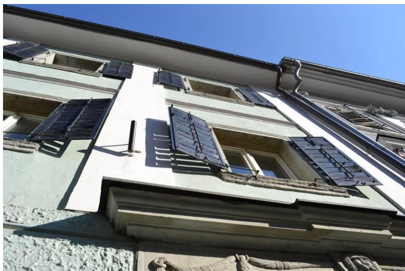
Slika 7: Protipožarna gradnja – železna polkna
