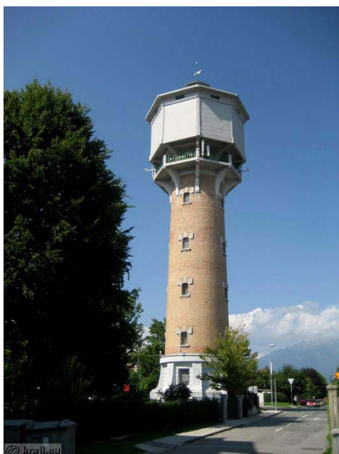
Slika 6: Vodni stolp, Kranj.
