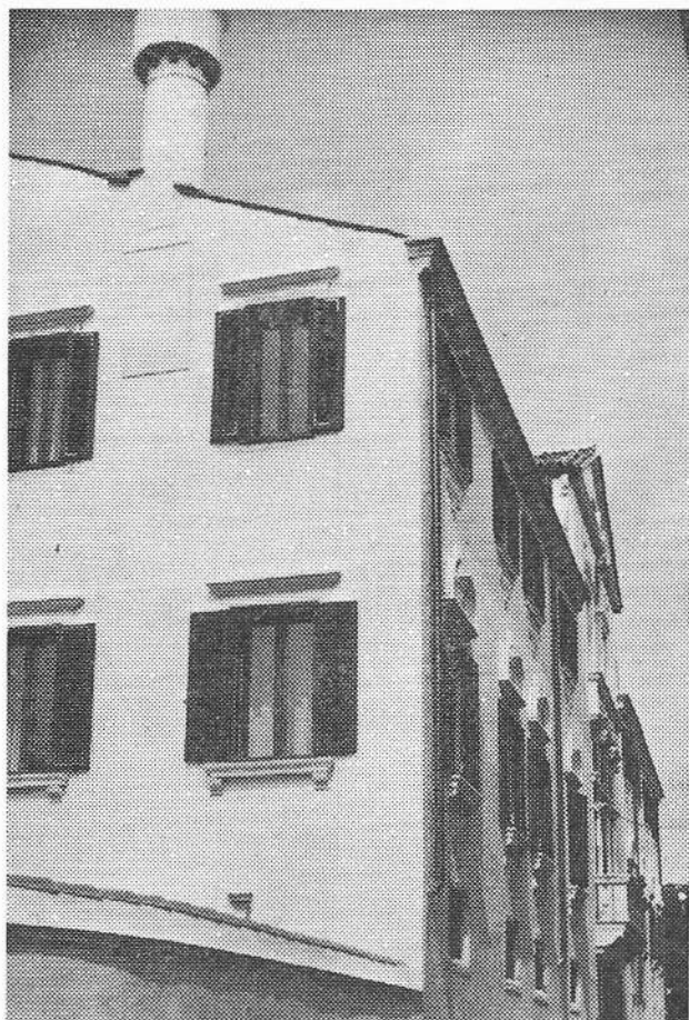
Glasbena šola po obnovi
