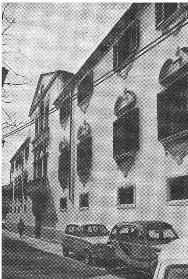
Glasbena šola po obnovi
