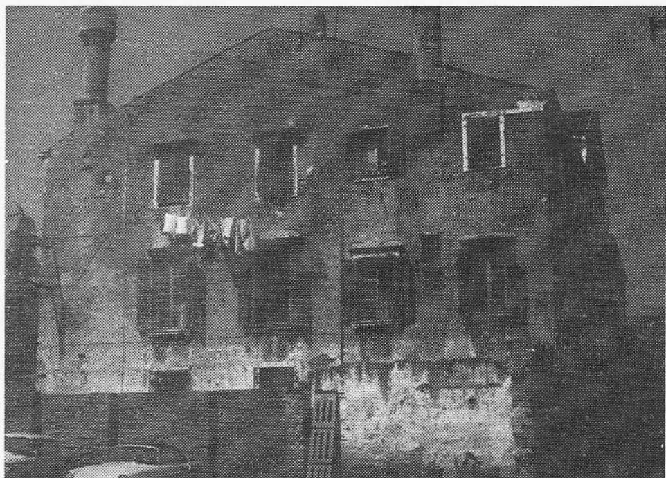
Glasbena šola pred obnovo
