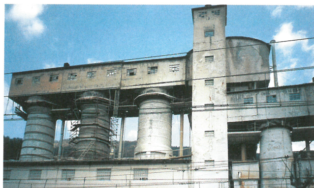
▲ Slika 18 V industrijskih pečeh za žganje apna poteka razkroj apnenca. Toploto je vseskozi treba dovajati, da reakcija poteka.
