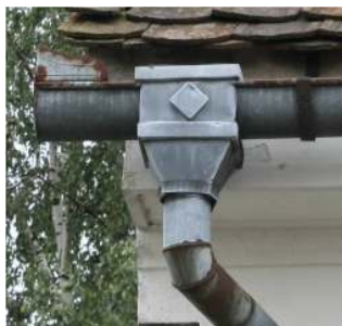
Obstoječi žlebovni zbiralnik na S fasadi.
