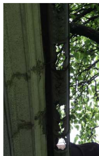
Dotrajani (desno) in žlebovi brez urejenega odтока (levo).
