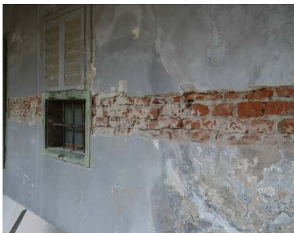
Zidni sonde na stanovanjskem (levo) in gospodarskem (desno) objektu.
