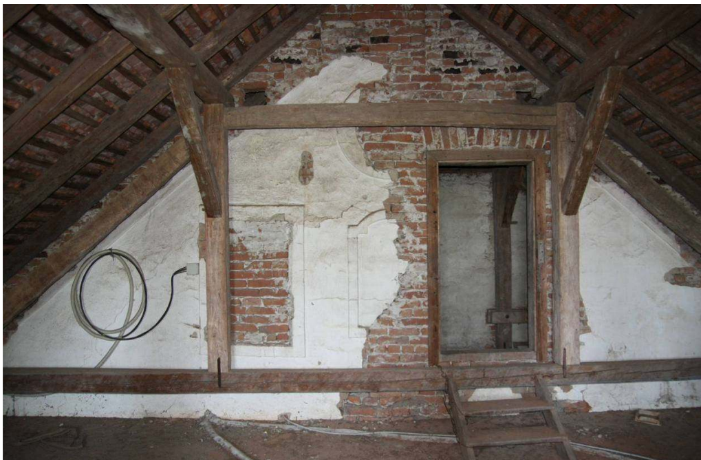
Fasadna stena na podstrešju kaže na dozidavo objekta proti vzhodu. Vidni dve zazidani okenski odprtini in s profilom naznačena slepa niša.
