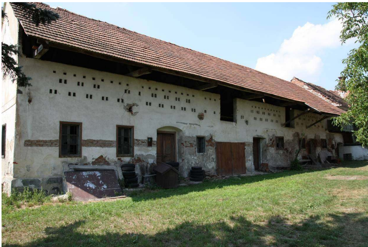
Pogled na gospodarski objekt iz JV.
