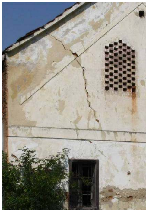
Ponekod so v zidovju vidne razpoke, ki kažejo na statične probleme.
