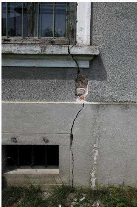
Ponekod so v zidovju vidne razpoke, ki kažejo na statične probleme.
