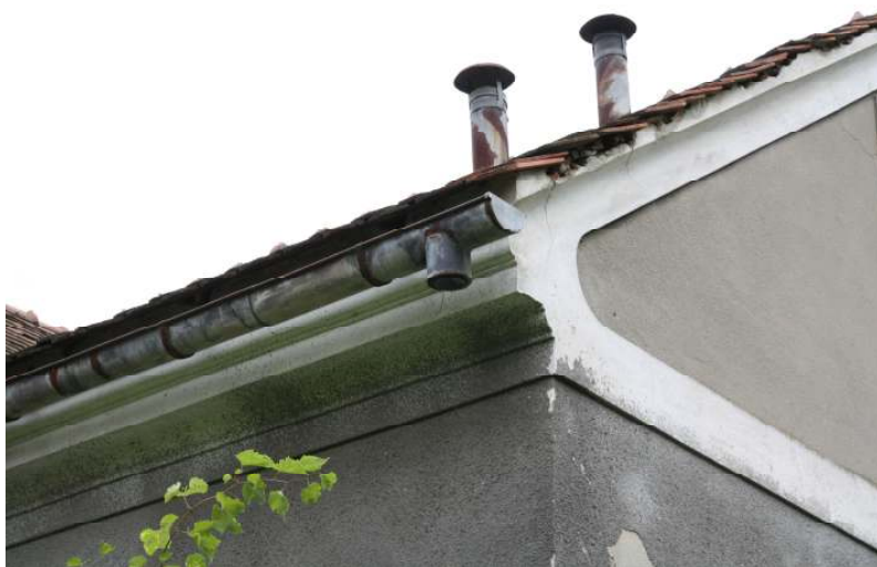
Dotrajani (desno) in žlebovi brez urejenega odтока (levo).
