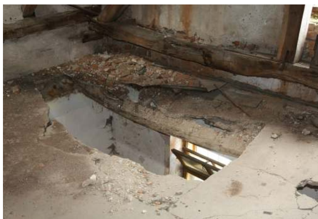
Delno porušen strop v JZ prostoru stanovanjskega objekta. Pogled iz prostora (levo) in iz podstrešja (desno).
