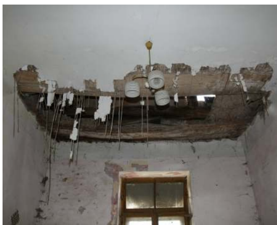
Delno porušen strop v JZ prostoru stanovanjskega objekta. Pogled iz prostora (levo) in iz podstrešja (desno).
