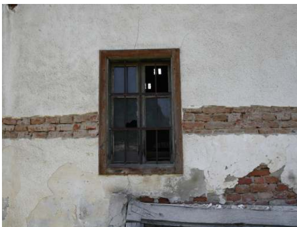
Zidni sonde na stanovanjskem (levo) in gospodarskem (desno) objektu.
