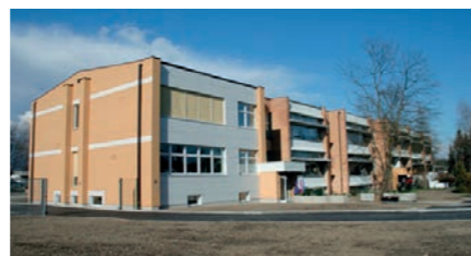
Zahodni prizidek na dan odprtja, 10. aprila 2013 (povzeto po domzalec.si).
