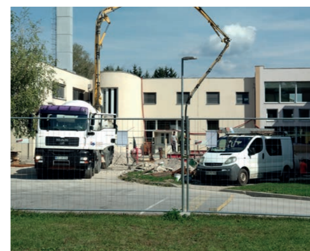
Gradnja nove šolske jedilnice, septembra 2020.
