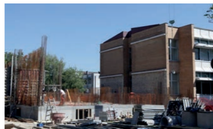
Gradnja zahodnega prizidka, avgusta 2012 (povzeto po domzalec.si).
